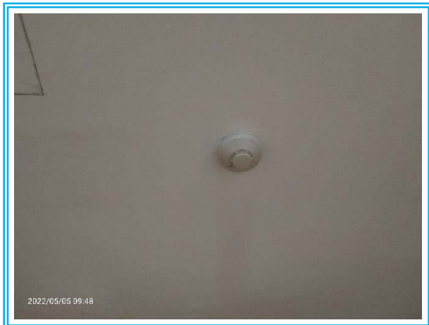
รูปที่ 2.5-10 เครื่องตรวจจับควัน
