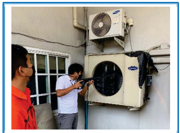
รูปที่ 3-47 การล้างเครื่องปรับอากาศบริเวณพื้นที่ส่วนกลาง
