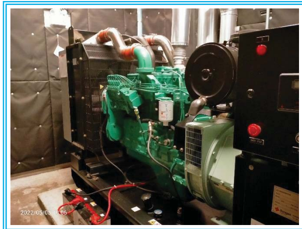
รูปที่ 2.5-8 เครื่องกำเนิดไฟฟ้าสำรอง
