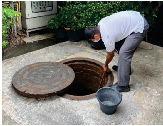
รูปที่ 3-32 ตักไขมันออกจากบ่อดักไขมัน
