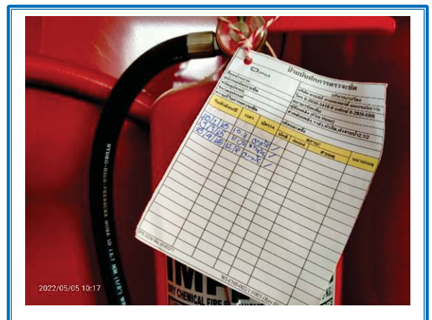
รูปที่ 3-41 บ้ายตรวจสอบถังดับเพลิง
