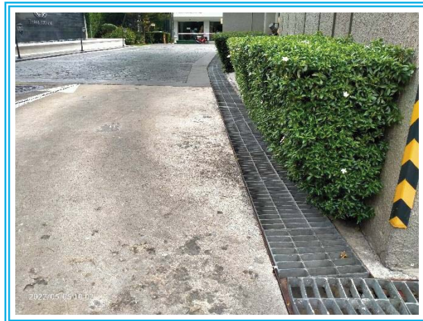
รูปที่ 2.5-2 ระบบระบายน้ำฝน
